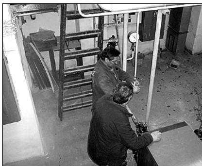
Oprava topení v ZŠ. Foto: A. Bárta
